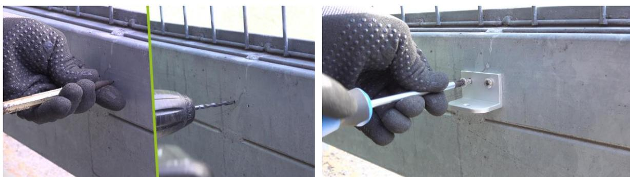
Después de haber medido correctamente, otra vez, marca y punza los agujeros con un cincel, después taladra los agujeros para la escuadra 2 utilizando una broca de 4,2 mm. Monta y fija la escuadra 2 con los tornillos adjuntados.
